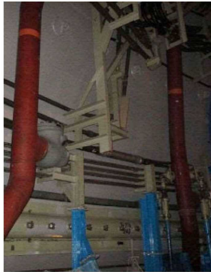
仮設足場組立前
