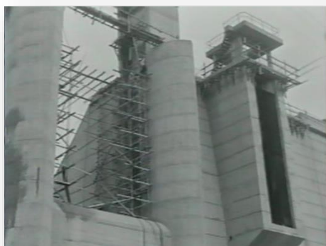
建設中の水沼ダム
