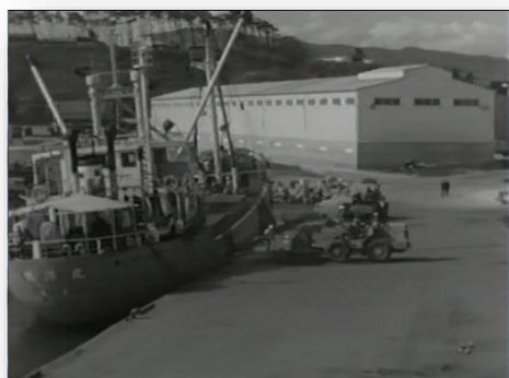
建設中の日立港
