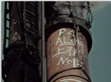
常磐自動車道建設工事
