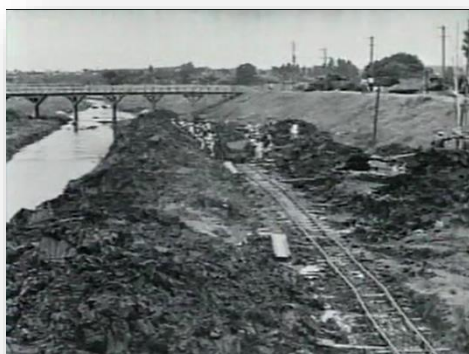
河川改修工事
