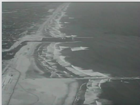
建設進む鹿島港
