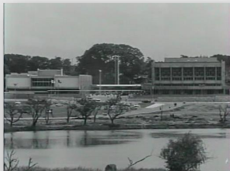
県民文化センター開館
