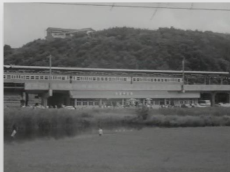
鹿島線開通(鹿島神宮駅)
