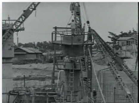
逆水門の工事はじまる
