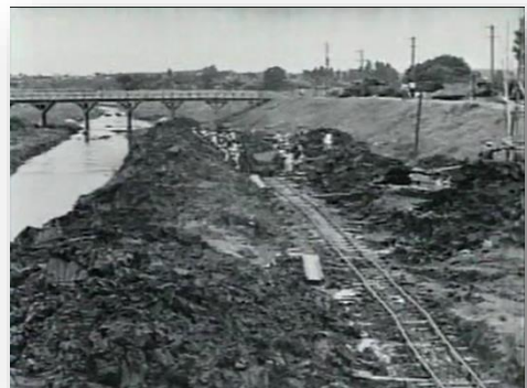
河川改修工事
