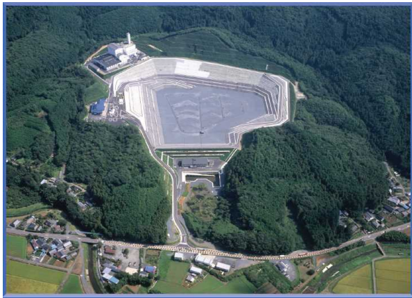
<エコフロンティアかさま> 開業：平成17年8月 埋立容量：240万 \text{m}^3 埋立進捗：約64%（H31.3.31現在）
