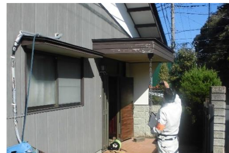
耐震診断士の診断作業の様子
