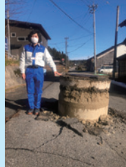
▲液状化により 浮き上がったマンホール
