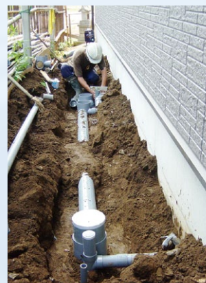
接続工事の様子
