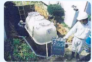
高度処理型浄化槽の設置
