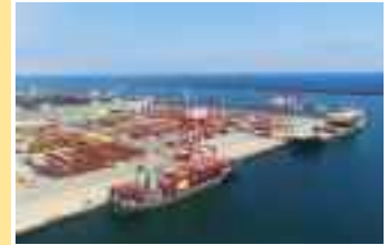
茨城港常陸那珂港区
