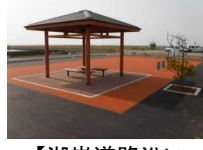
【湖岸道路沿いの休憩施設】
