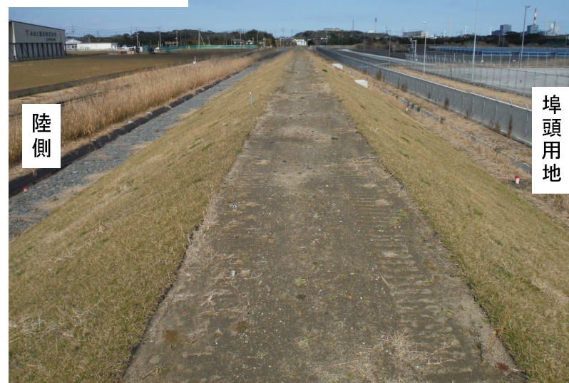
①防潮堤完成
