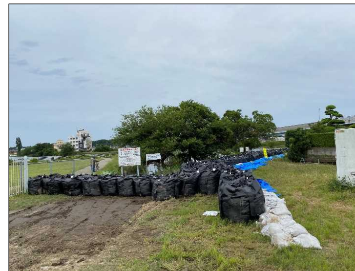
大型土のう設置後
