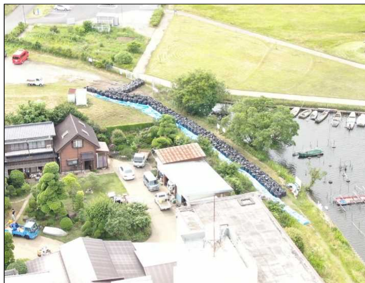
大型土のう設置後
