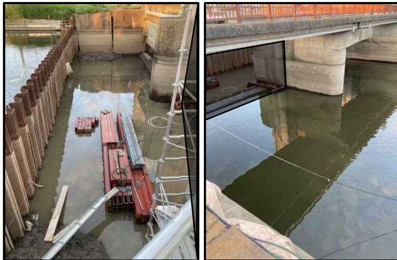
矢板締切内で、旧ゲート及び旧戸当金物を撤去。
