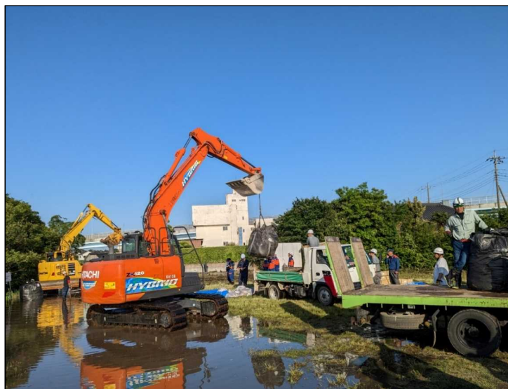
大型土のう設置作業中
