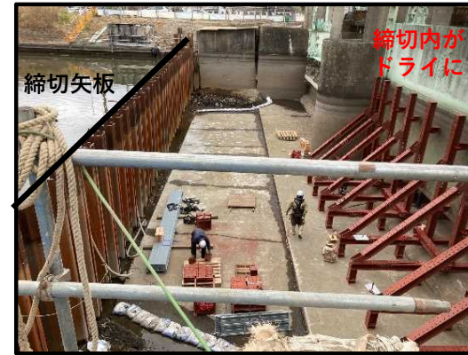
ゲートや戸当金物の撤去・設置作業や底板状況確認のため、矢板で河道全川を締め切り、中の水を抜き、ドライな作業環境を確保。
