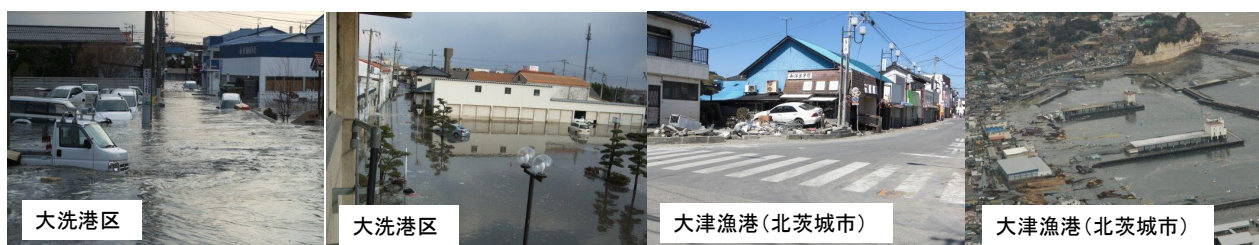
東日本大震災における港湾・漁港背後地の浸水状況
