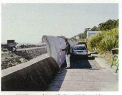
写真-6 新旧護岸の端部比較(護岸高の差は1m)
