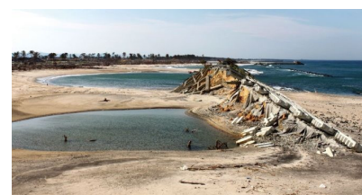
東日本大震災の被害(宮城県山元町)
