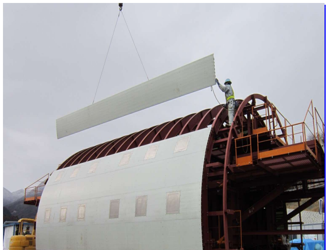
FRP組立③
