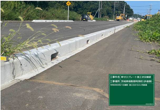
舗装後6ヶ月経過
