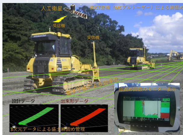
■道路工事の盛土(R4d)
