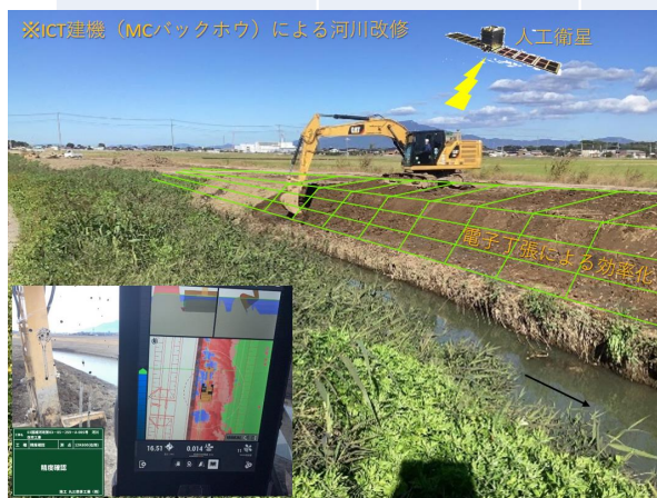
■河川工事の掘削(R4d)
