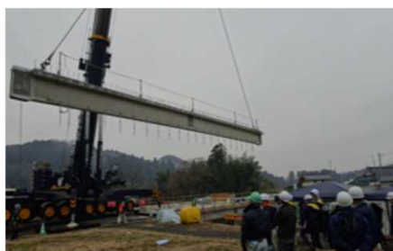
橋梁技術研修
