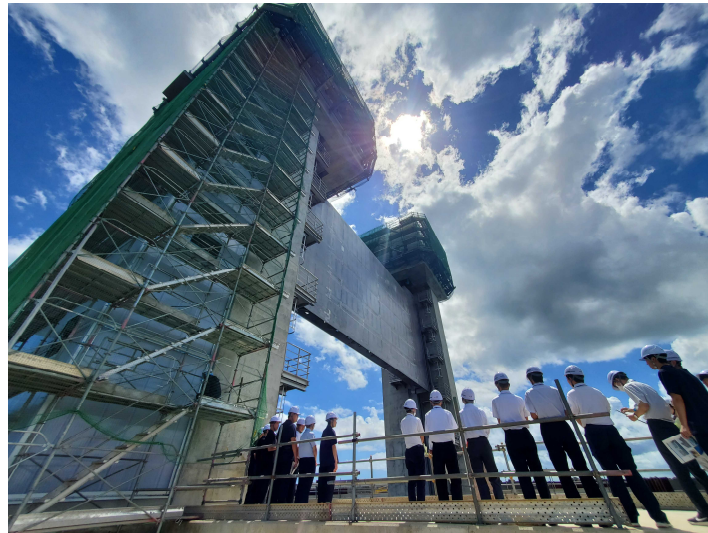
大洗水門工事
