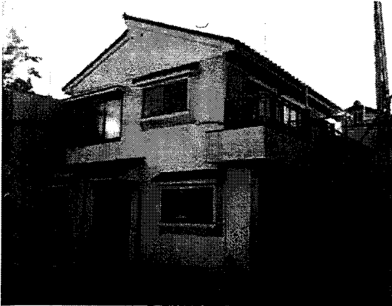
b. 既存建物と養生シート
