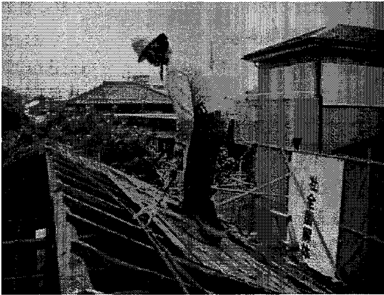
m. 屋根の解体
