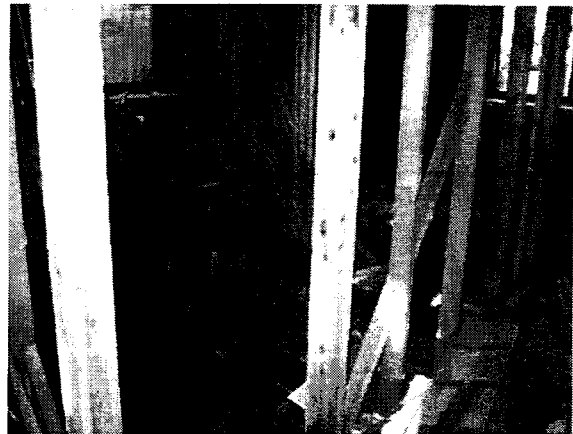
c. 内部造作の撤去
