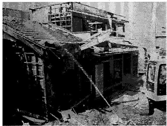
n. 桁側からの解体
