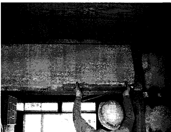
k. 石膏ボードの撤去
