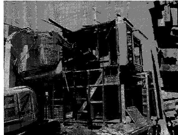
p. 2階妻側からの解体
