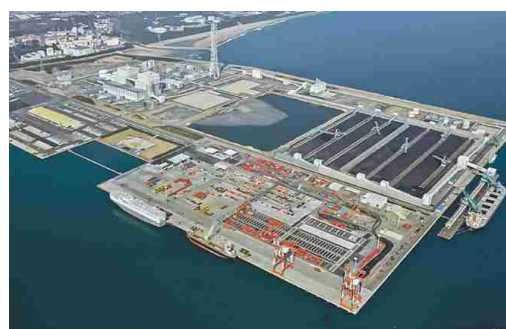
(株)JERA常陸那珂火力発電所と揚炭バース
