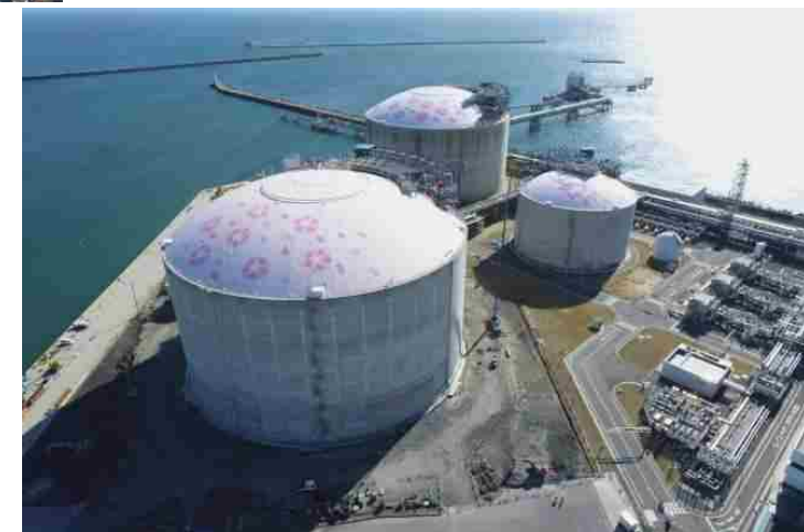
LNG基地 2号タンク令和3年3月より運転開始 (東京ガス(株)HPより引用)
