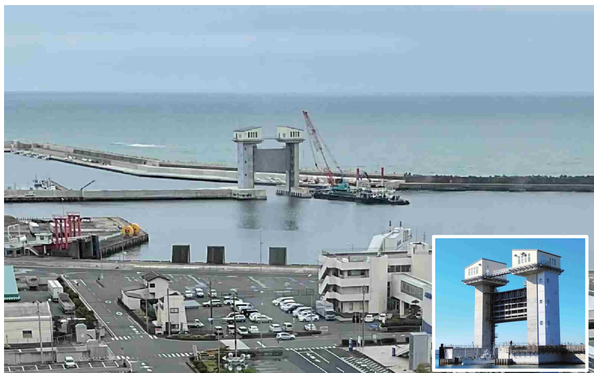
大洗港区 津波高潮対策のための水門
