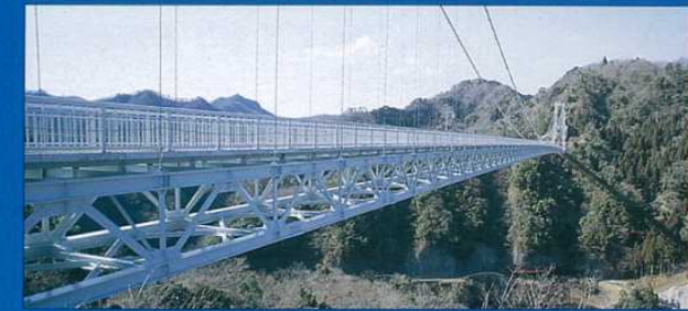
駐車場からみた吊橋
