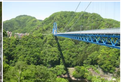
⑨竜神大吊橋を望む
