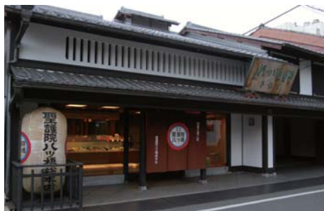
聖護院八ッ橋総本店 平成25年度京都景観賞 京都府京都市左京区
