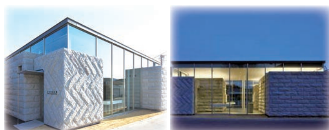
石の百年館建設工事
