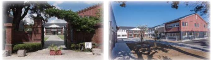
古河第一小学校校舎改築事業（古河市）
