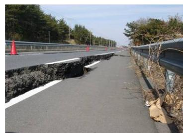
一般国道51号の亀裂・沈下
