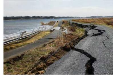
涸沼の堤防・護岸の崩壊
