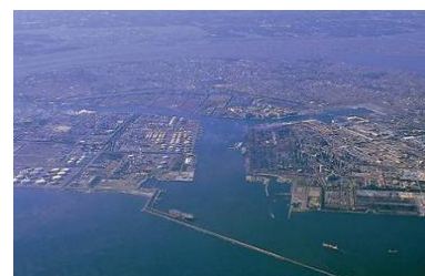
港湾の整備(鹿島港)
