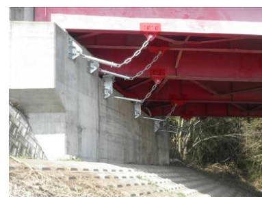
橋梁の耐震対策(筑西市)
