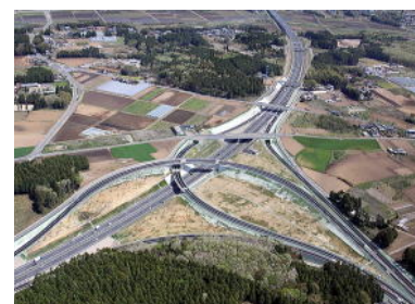
広域的な幹線道路の整備 (茨城町JCT)
