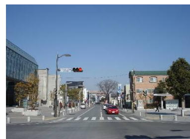
避難路となる幹線道路整備(筑西市)
