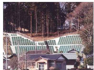
急傾斜地整備による防災性向上 (石岡市)
