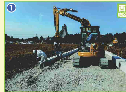
① 区画街路築造工事(側溝敷設)
