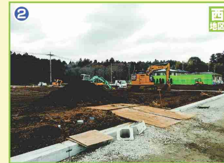
② 宅地整備工事
