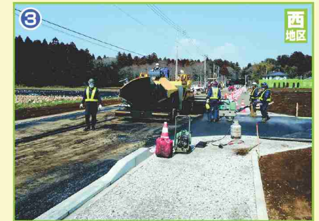
③ 区画街路築造工事(上層路盤舗装)
