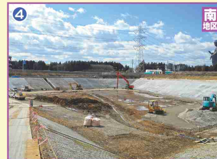
④ 調整池護岸工事
