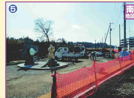
⑤ いぶきロードサイド広場整備工事
