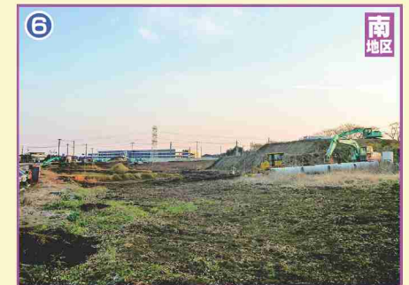
⑥ 造成工事
