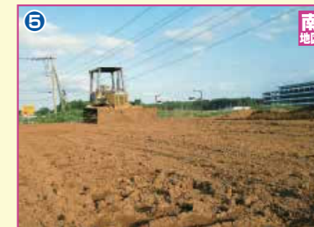
宅地造成工事
