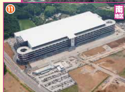
完成間近! マルチテナント型物流センター 『DPL つくば阿見』!
