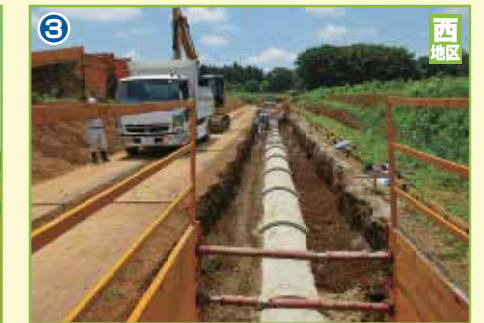
供給処理施設の敷設工事
