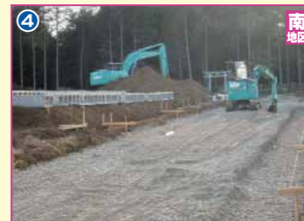
道路改良工事
