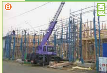
進む住宅建築
