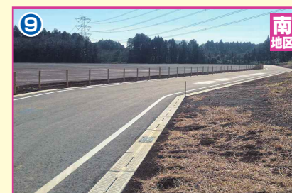
9 開通した町道6444号線(S36街区外周道路)
