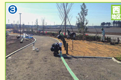
3 ふれあいの杜公園整備工事
