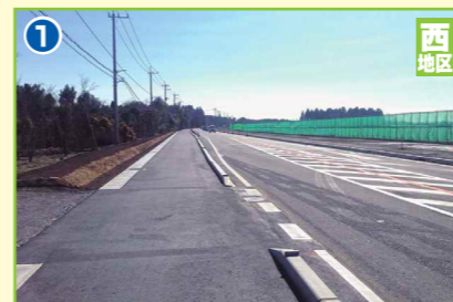
1 国道土浦稲敷線拡幅工事(一部供用開始済み)
