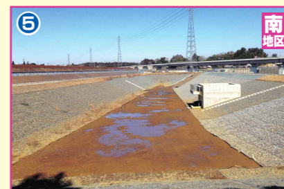
5 完成間近の第2調整池
