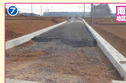
7 道路改良舗装工事(区画道路)
