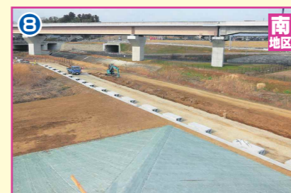
8 道路築造工事(第2調整池外周)
