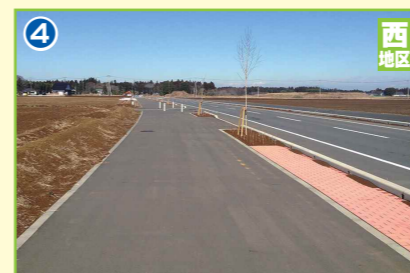
4 赤太郎通り歩道整備工事
