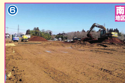
6 宅地造成工事
