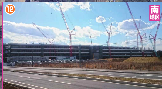
12 マルテナント型物流センター(DPLつくば阿見) 建設中
