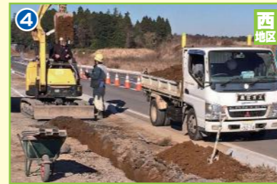
4 上下水道・ガス管敷設工事
