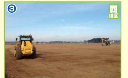
3 大街区造成工事
