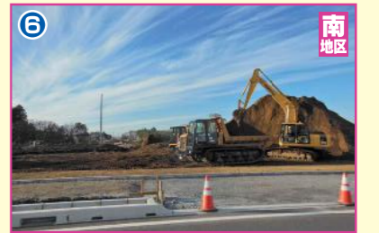
6 宅地造成工事
