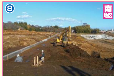
8 第3調整池整備工事
