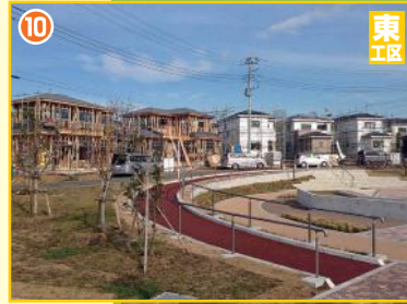
進む住宅建築工事
