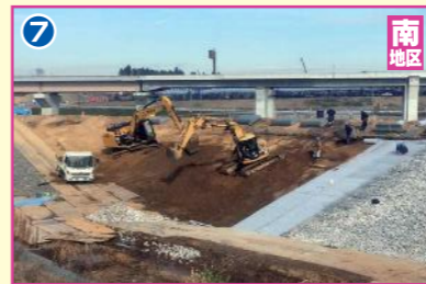
7 第2調整池整備工事
