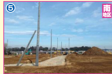
5 道路改良舗装工事(区画道路)
