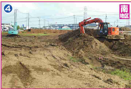
宅地造成工事
