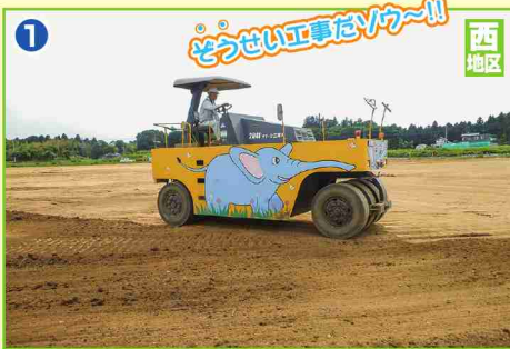
宅地造成工事
