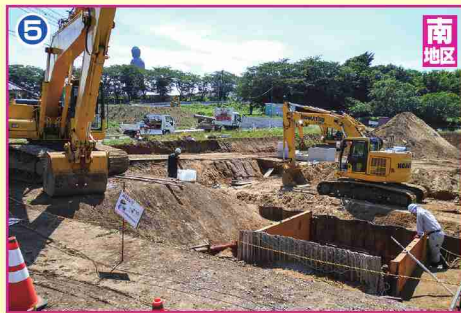
第4調整池整備工事
