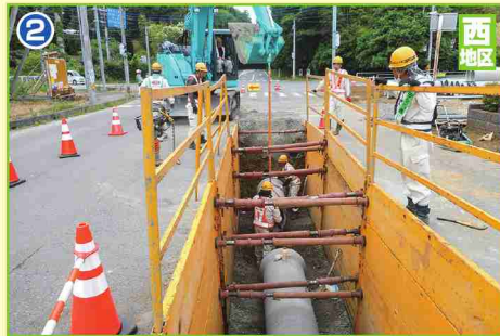
下水道整備工事
