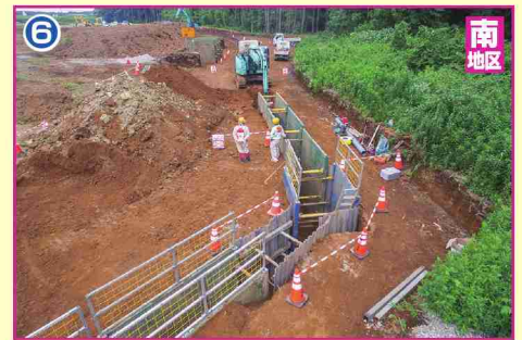
下水道整備工事
