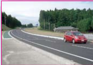
祝開通 県道竜ヶ崎阿見線BP(追原区間)
