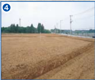
4 商業・業務施設用地の造成工事
