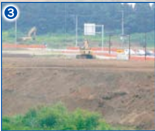
3 進む宅地の造成工事
