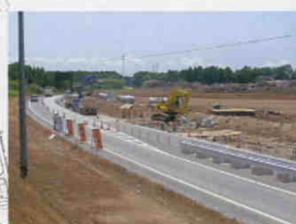
▲供給処理施設の敷設工事(薬師山通り線)
