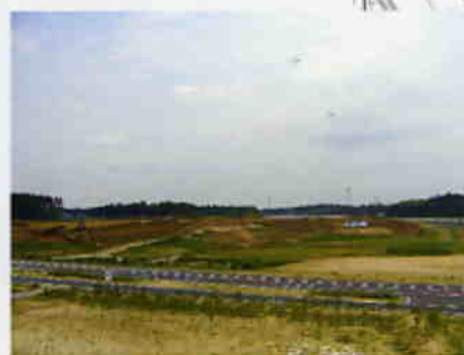
▲商業・業務施設用地の造成工事
