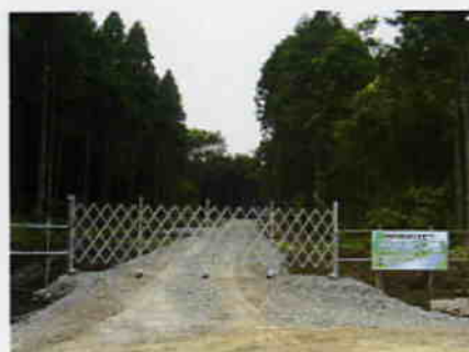
▲ストックヤード(土工事 盛土材の仮置場)の入口
