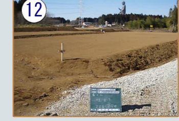
造成工事(宅地整備工事)
