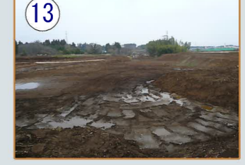
造成工事(第三調整池予定地)
