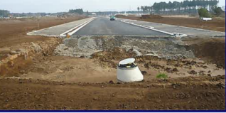
⑨ 道路築工事 (地区界扱い区画道路)
