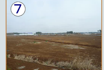
造成工事(宅地整備工事)
