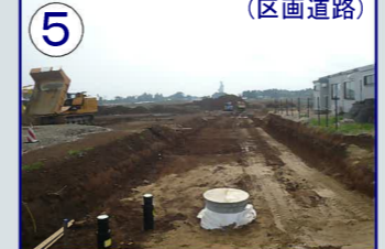
道路築造・供給処理施設工事 (区画道路)
