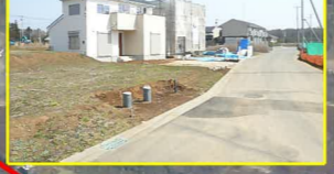
② 進む住宅建築工事
