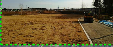
① 近隣公園、調整池工事
