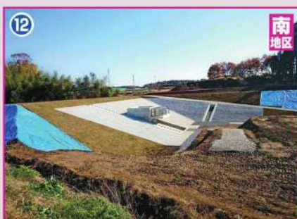
第3調整池築造工事
