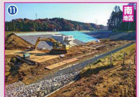
第2調整池築造工事
