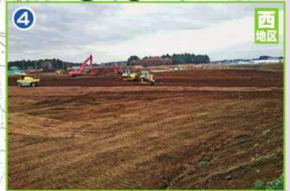
宅地造成工事 ※伐採伐根工事含む
