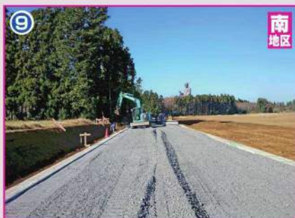
道路築造工事(久野側:地区界道路)
