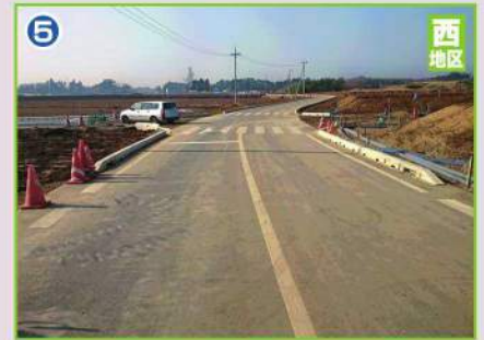
整備された町道0207号線
