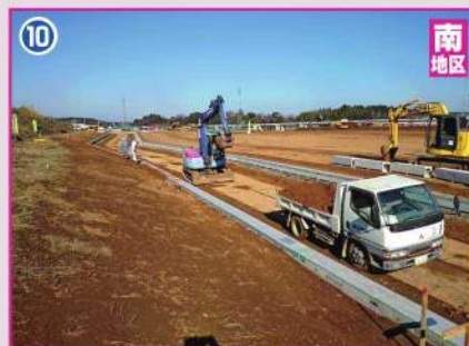
道路築造工事(桂側:地区界道路)
