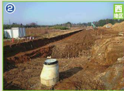
供給処理施設敷設工事(赤太郎通り)
