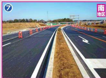
道路築造工事(県道BP4車線化)
