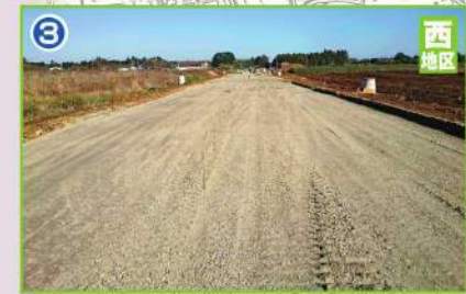
道路築造工事(赤太郎通り)
