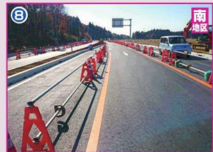
道路築造工事(県道BP4車線化)
