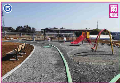
⑤ 完成間近【緑地公園（仮称）】
