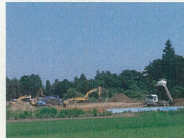
②防災調整池工事の様子
