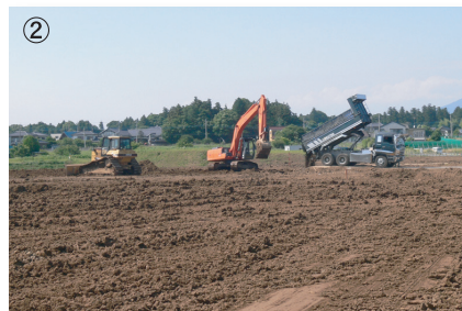
地区北側の一般宅地の工事の様子
