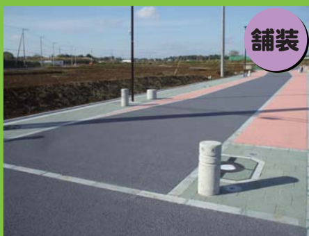
遮熱性舗装(コミュニティ道路)
