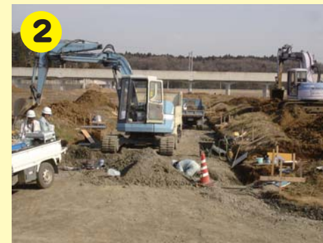
島名環状線内側の区画道路工事の様子
