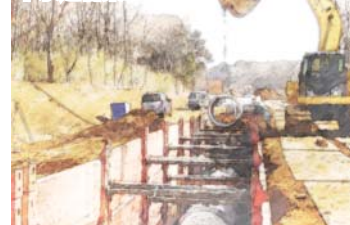
下水道管渠工事
