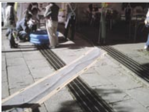
写真5 安全のための配線の被覆
