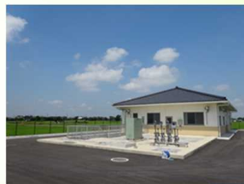
農業集落排水施設
