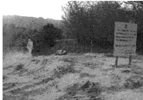
埋め戻し後、看板設置（写真 23）
