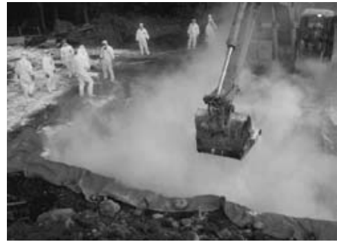
埋却溝への消石灰散布（写真 19）
