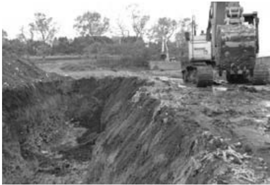
パワーショベルで穴を掘削（写真 18）
