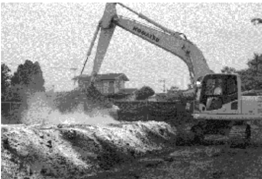
埋め戻し後消石灰散布（写真 22）
