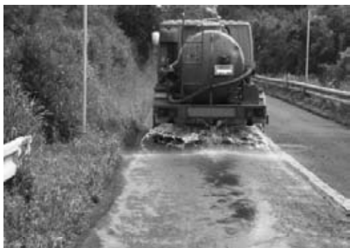
散水車による路上消毒（写真 62）
