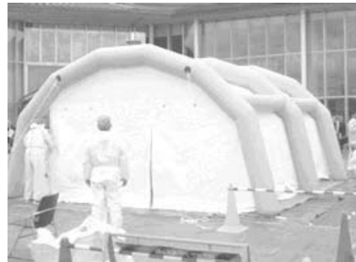
除染テント（写真2）
