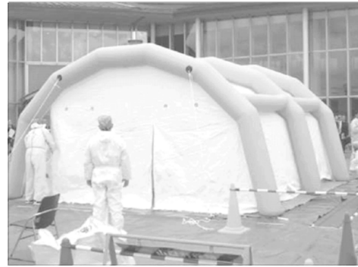
除染テント (写真 43)
