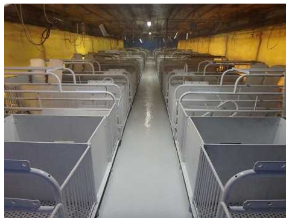
写真 2 石灰乳塗布後の分娩舎
