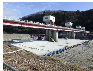
辰ノ口堰 補修工事
