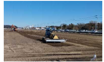
仕上げ整地の状況
