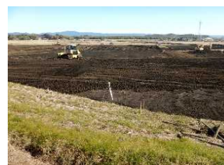
瓜連地区 整地工事
